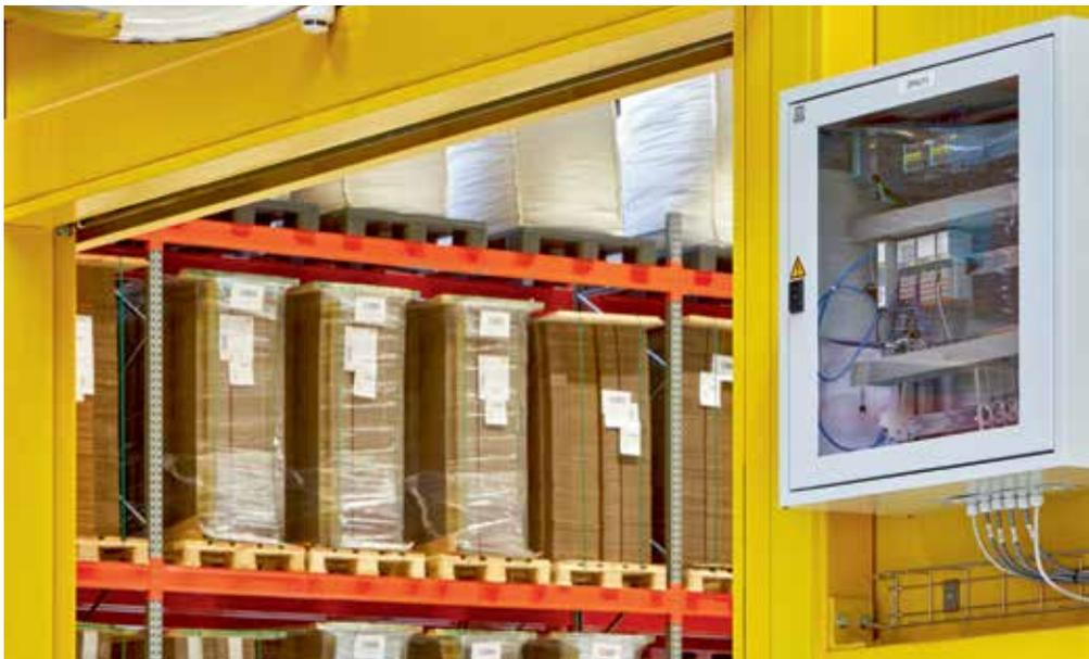
Avec l'automate AXC Cloud-Pro et les modules d'E/S juxtaposés, le système récupère les données des capteurs de températures répartis dans les différents espaces de stockage
